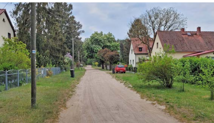
Bild 57 Straße vor dem Ausbau (Wustrau) / © MIL
