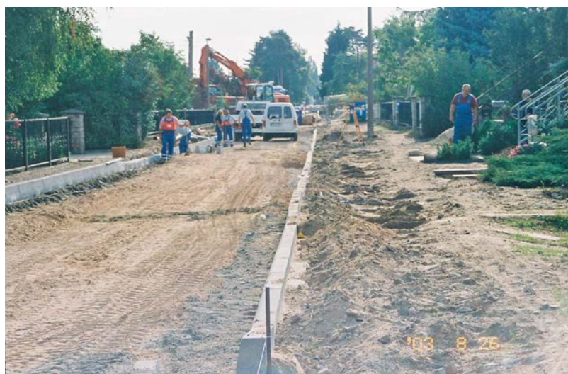
Bild 71 Tiefeinbau / © Stadt Ludwigsfelde
