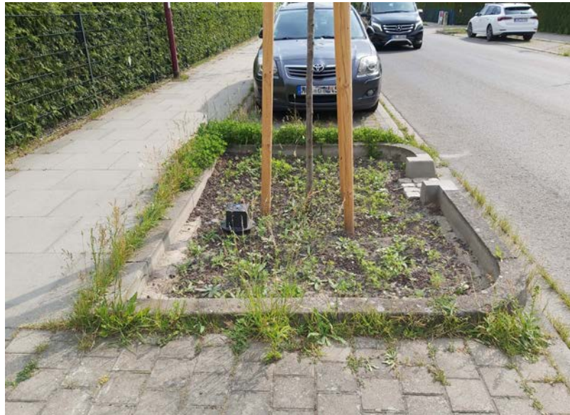
Bild 26 Beet und Baumentwässerung (Hoppegarten) / © MIL
