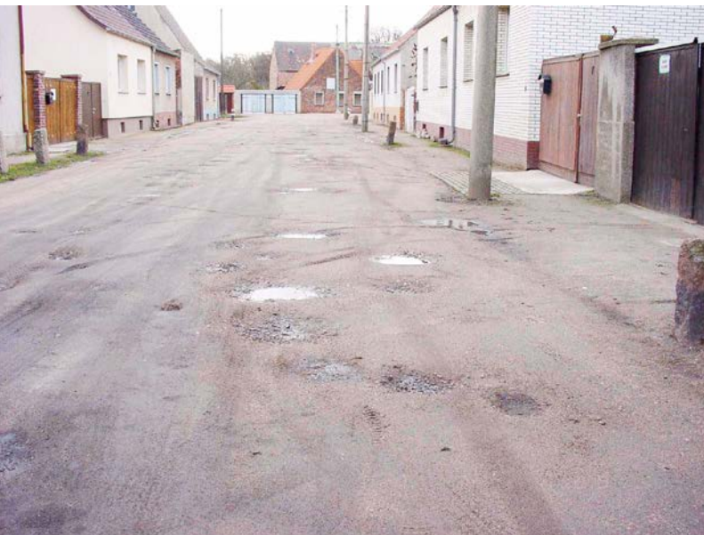
Bild 63 Wohnstraße mit ungebundener Deckschicht vor dem Ausbau / © MIL
