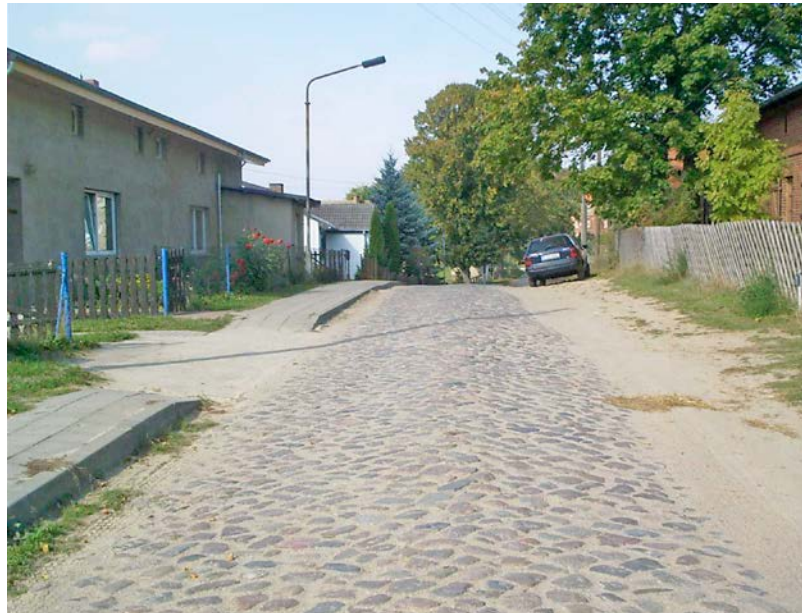
Bild 64 Wohnstraße mit Pflasterbefestigung vor dem Ausbau / © MIL
