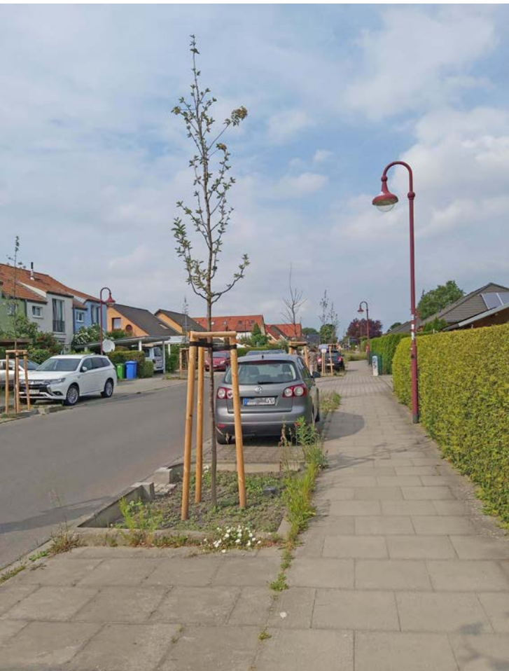
Bild 6 Entwässerung (Neuenhagen) / © MIL
