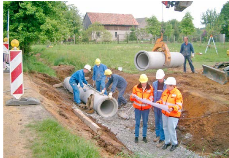
Bild 53 örtliche Bauüberwachung / © MIL
