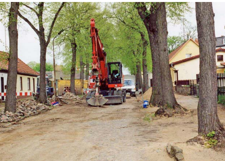
Bild 59 Bauausführung (Rheinsberg) / © MIL
