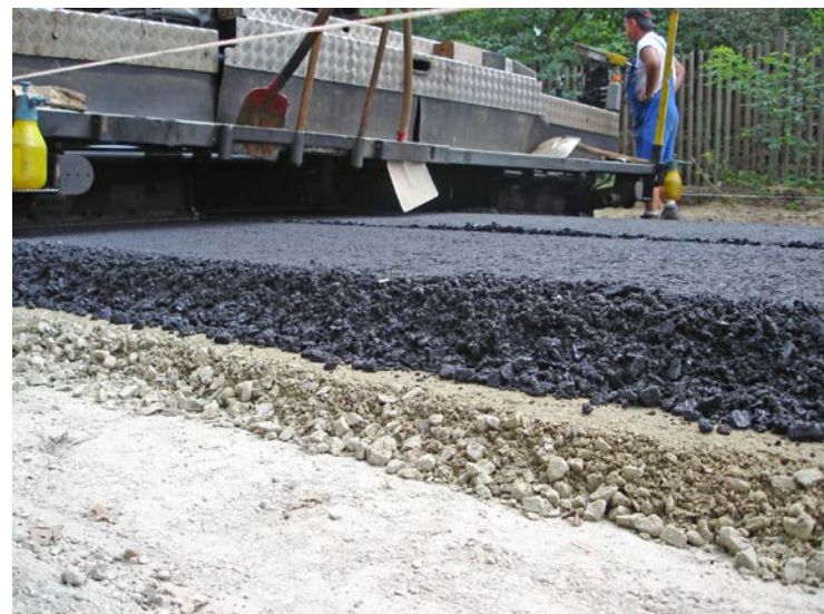
Bild 73 ungebundene Zwischenschicht 0/22 (8 cm dick) / © LS
