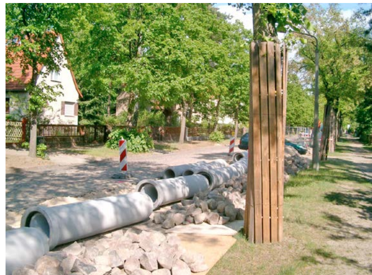
Bild 52 Leitungsverlegung / © MIL
