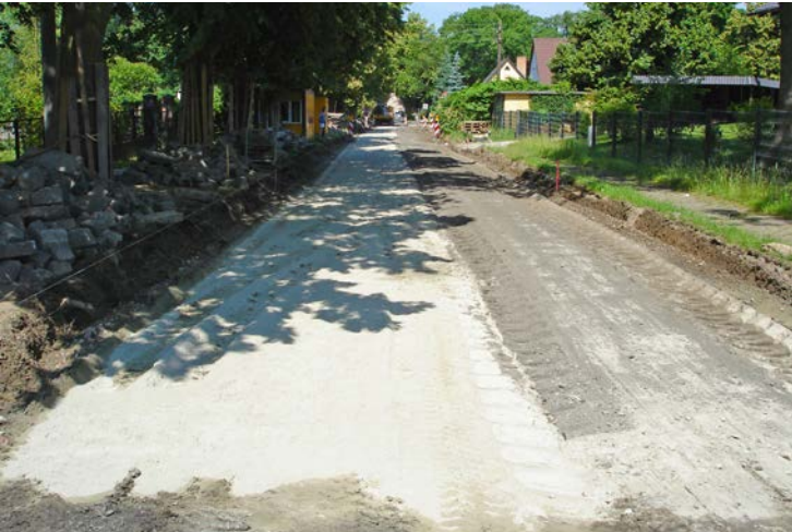
Bild 43 Herstellung einer Zementverfestigung (Neuenhagen) / © LS
