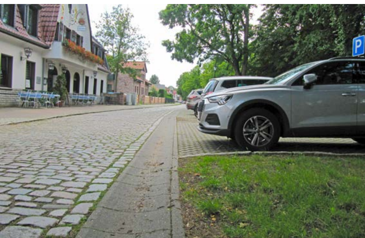
Bild 23 Parken und Entwässerung (Blankenfelde) / © LS
