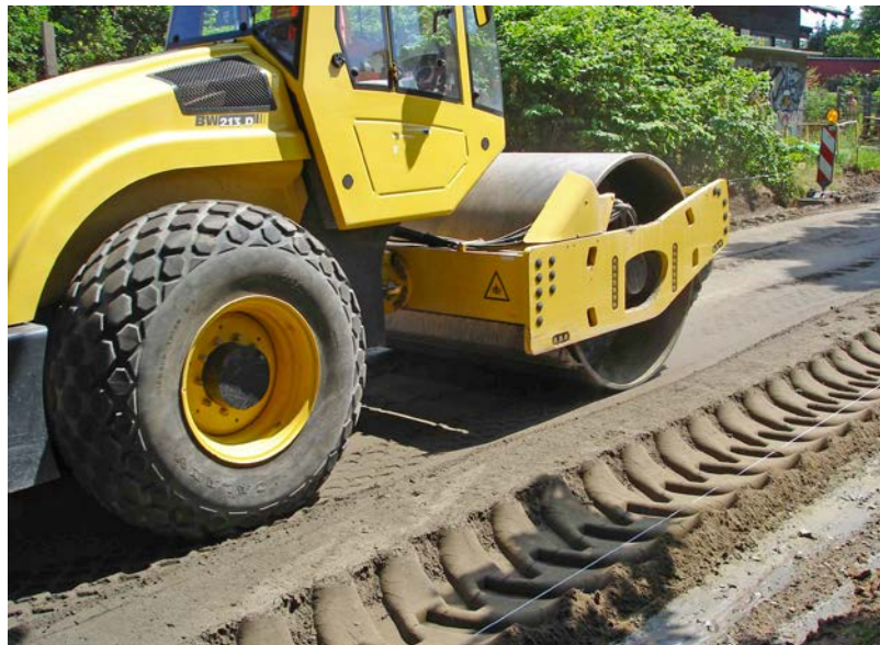
Bild 45 Herstellung einer Zementverfestigung (Neuenhagen) / © LS
