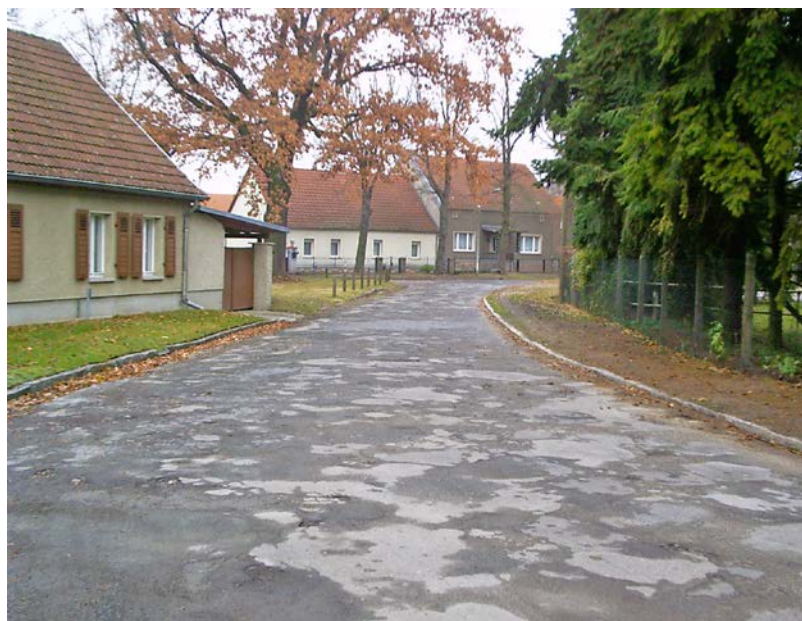
Bild 66 Wohnstraße mit alter Asphaltbefestigung / © MIL
