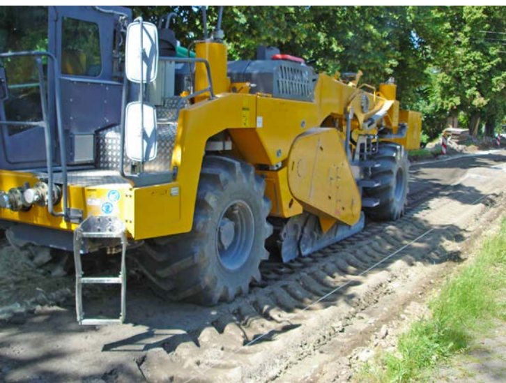
Bild 44 Herstellung einer Zementverfestigung (Neuenhagen) / © LS
