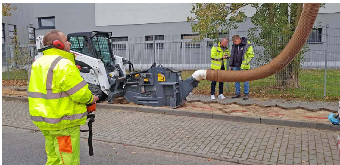
Bild 47 Bauweise mit Bagger und Grabenfräse / © LS
