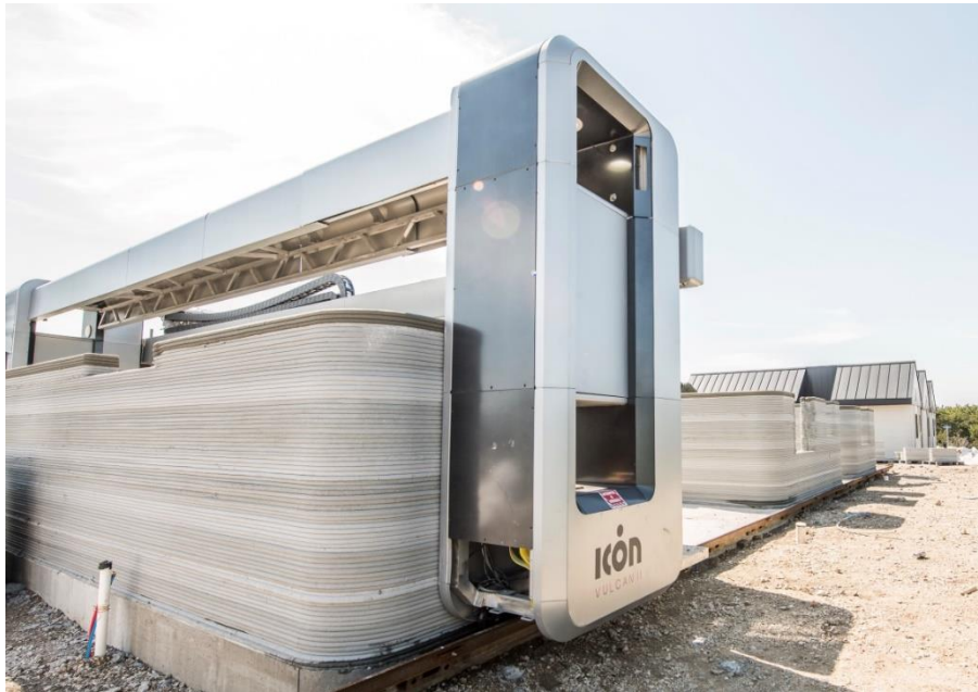
Abb. 4.3 3-D-Maschine: Manipulator und Druckkopf
