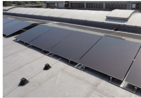
Abbildung 3: Nicht ausreichende Trennungsabstände (li.) und überbaute Bauteile (re.) beeinträchtigen Blitzschutzsysteme (Foto: THOR-DONAR GmbH Hamburg)
