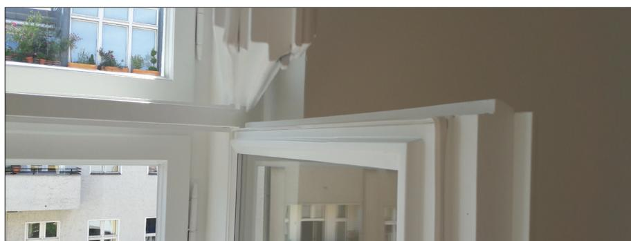
Detailansicht eines runderneuerten und energetisch ertüchtigten Fensters: Vollständig durchrepariert, entlackt, neu beschichtet und verglast, Aufdopplung des Innenflügels zur Aufnahme eines Wärmeschutzglases, Einbau hochwertiger Dichtungen.
