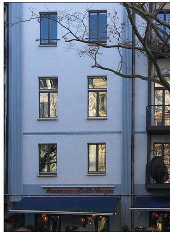
Der Unterschied zum Kastenfenster mit einfach verglastem Außenflügel wird bei Fenstern mit Wärmeschutzverglasung außen besonders deutlich. Manche Gläser sind so beschichtet, dass sie beinahe spiegeln. Bei den hier abgebildeten wird zusätzlich die Wölbung des Isolierglases in der Spiegelung deutlich. Die Vereinfachung der Fenstergliederung bleibt ebenfalls nicht ohne Wirkungen auf das Stadtbild. (Mitte, 2022).
