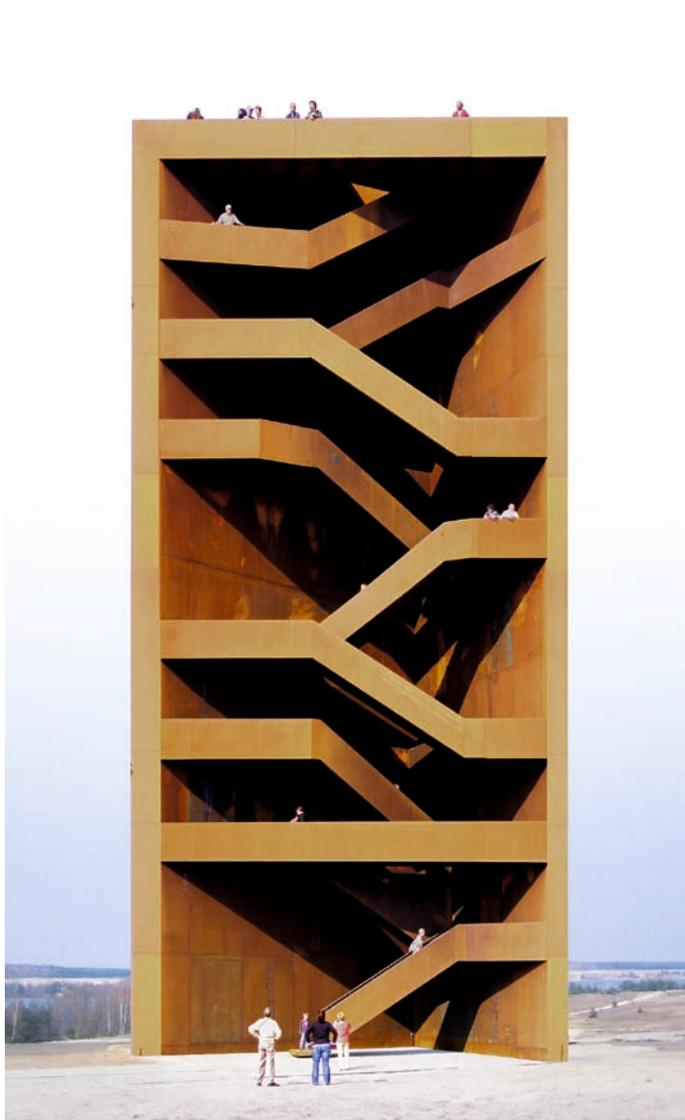
Konstruiert ist der Turm wie ein Schiff. Er besteht aus 6 mm dicken Blechen, die wie im Schiffsbau durch innen liegende Rippen ausgesteift und verbunden sind. Alle Stahlbleche sind nicht nur formbildende, sondern gleichzeitig auch statisch wirksame Konstruktionselemente. Der Turm besteht aus wetterfestem Cortenstahl, der mit der Zeit eine Patina aus Rost ansetzt. Daher wird der Turm wie die umgebende Seenlandschaft im Lauf der Jahre seine Erscheinung verändern.
