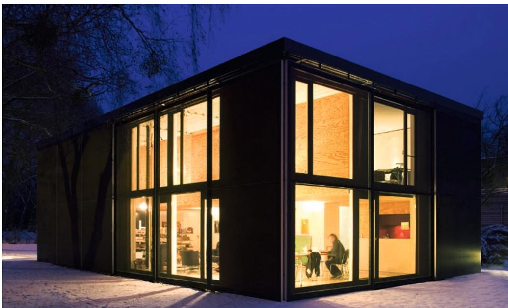
Auf das Nötige reduziert ist das Stahltragwerk prägend im Raum. Weitgehend verglaste Außenwände ermöglichen die optische Verbindung zwischen Innen und Außen. Dabei gewährt die verschiebbare, großflächige Gewebefassade Sichtbeziehungen und schränkt diese ein. Zusätzlich ist deren energetischer Effekt im Sommer und im Winter nachvollziehbar. Die Gewebefassade prägt die Gebäudegestalt wesentlich.
