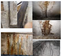
SB Bautechnik – eigene Baustellenbilder 2014 bis 2026 Verschiedene Bauvorhaben in Berlin und Potsdam
