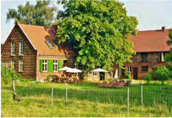
Der fertig gestellte ökologisch sanierte Flusshof im Sommer 2010
