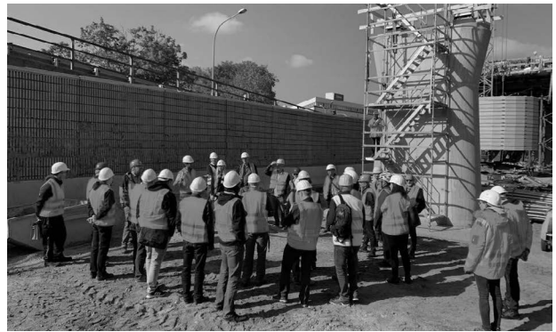
Baustellenbesichtigung | Foto: BBIK
